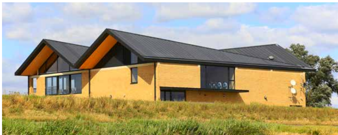
Cambridge University Boathouse Building (UK) - Architecte : Baynes & Mitchell Architects - Entreprise : TR Freeman
