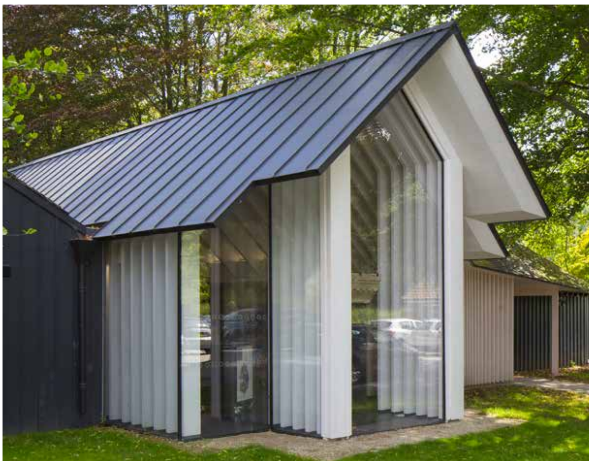
Rievaulx Abbey, York (UK) - Architecte : Simpsons & Brown - Entreprise : Varla
