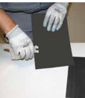
Traceren van de overlappende delen
