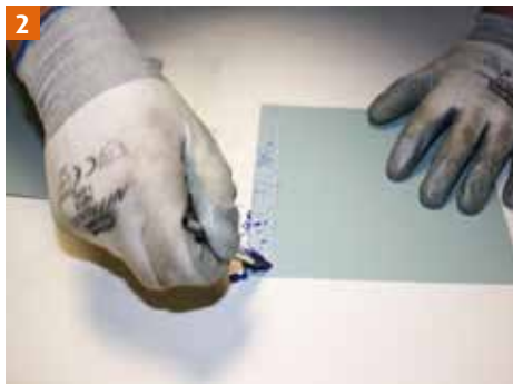
2 Aanbrengen van een afbijtmiddel.
