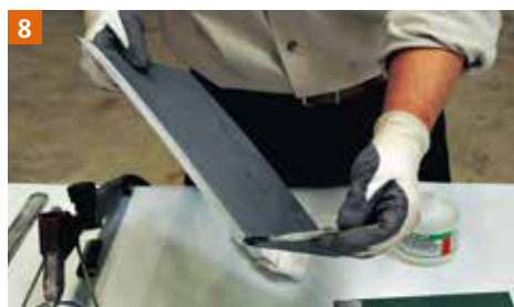
8 Niet vergeten de onderzijde te behandelen met Deca VMZINC.
