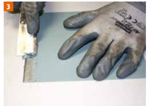
3 Verwijderen van de laklaag met een spatel.
