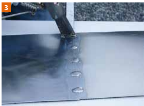
3 Vertinnen van de soldeerbout op de ammoniaksteen. Puntsoldering van de te solderen delen.
