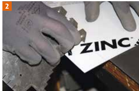
2 Traceer de ZINC PLUS laag. Verwijder de film van de overlappende delen.
