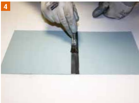
4 Breng plaatselijk Zinn 7 aan om goed te kunnen solderen. Breng de 2 te solderen platen samen volgens schema p 6 - 7.
