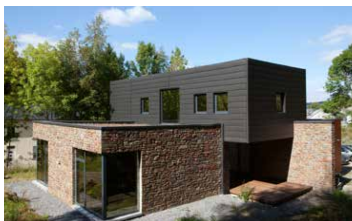
Architecte: François Colson
