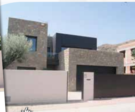
Casa unifamiliar, Gerb (Lerida)
